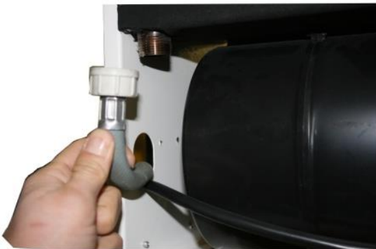
4 Plastikabdeckung abschrauben.
